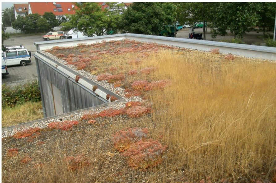
Abb. 4: Dachbegrünung des Hauses der Artenvielfalt.
