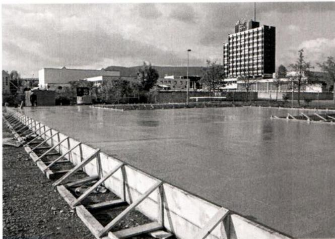
Abb. 2: In der zweiten Oktoberhälfte entstand die Schmutzbetonschicht.
