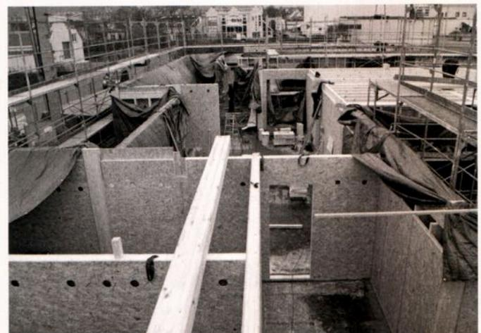
Abb. 6: Am 22. Januar stehen alle tragenden Wände des Erdgeschosses und es wird mit dem Deckeneinbau begonnen.
